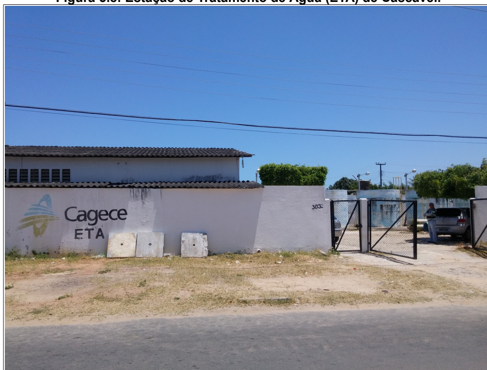
Figura 5.8: Estação de Tratamento de Água (ETA) de Cascavel.
