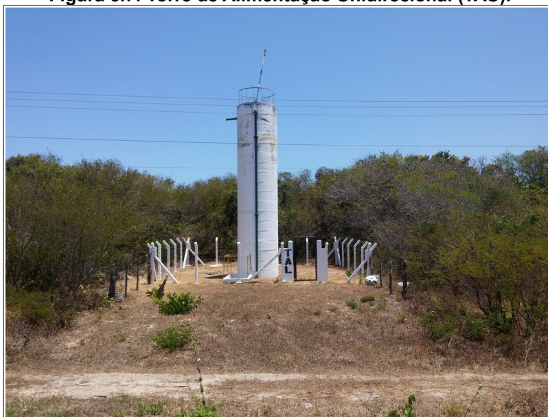
Figura 5.7: Torre de Alimentação Unidirecional (TAU).
