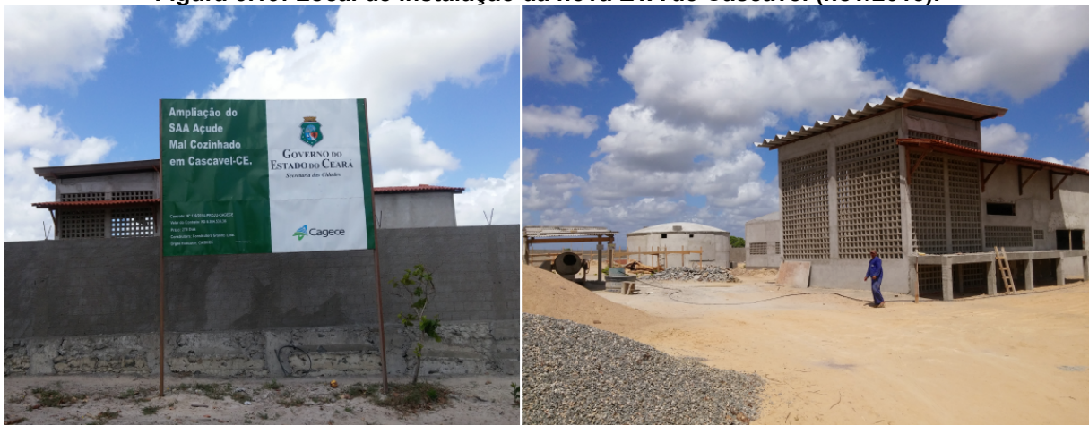
Figura 5.19: Local de instalação da nova ETA de Cascavel (nov/2015).
