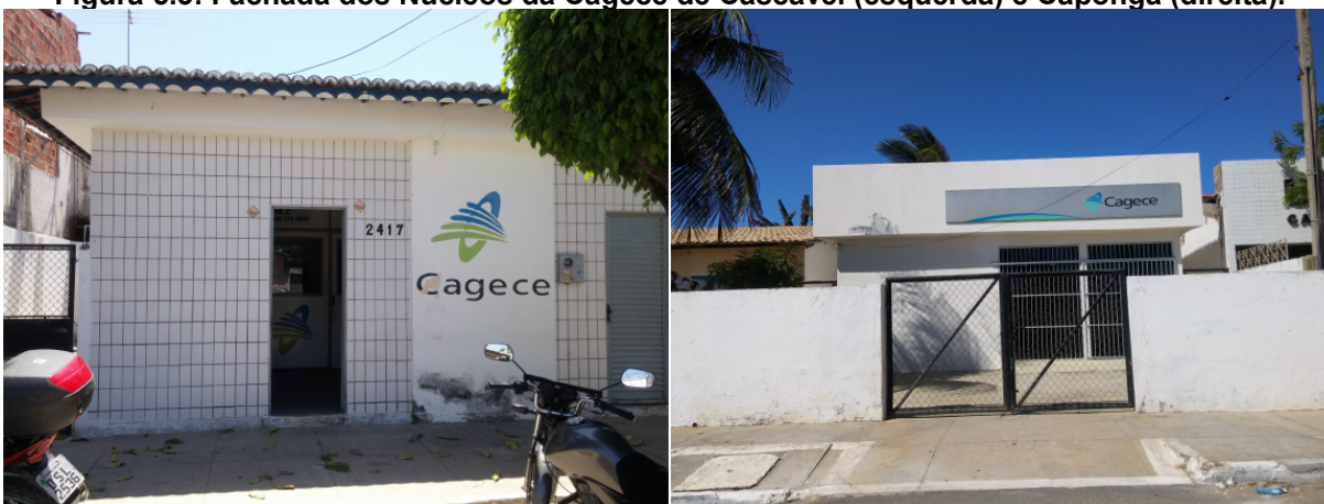
Figura 5.3: Fachada dos Núcleos da Cagece de Cascavel (esquerda) e Caponga (direita).
